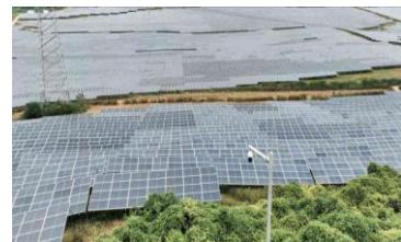
设备640×512的热成像分辨率与25mm镜头组合，在10米高度部署时可单次覆盖约30m<sup>2</sup>的光伏阵列区域，
